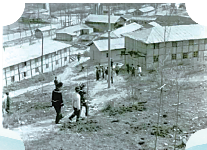
20世纪80年代初，建设中的花溪校区(临时教室与宿舍)。
