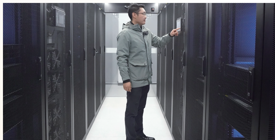
贵州省地质调查院副总工程师、总工程师曾禹人正在检查数据库的机房。
