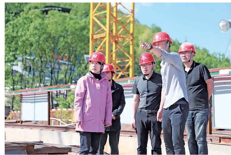
张胜林（左一）在项目建设现场。本报记者 刘力维 摄
