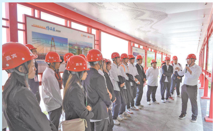
贵州交职大师生在建设中的花江峡谷大桥项目现场进行现场教学。
