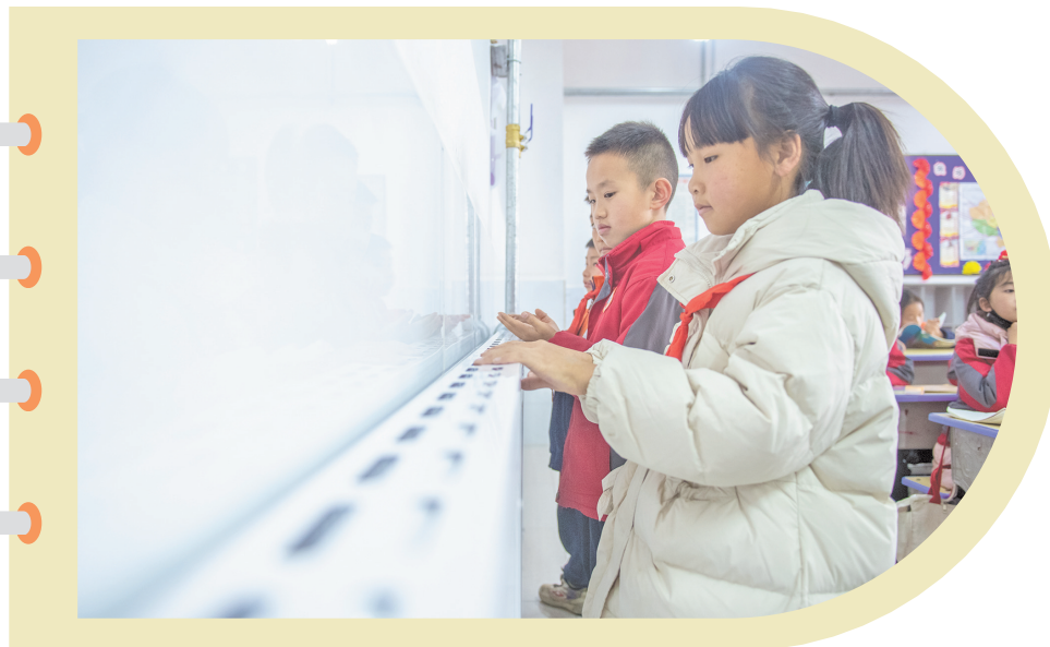
新桥小学学生课间时间在暖气片旁取暖。
