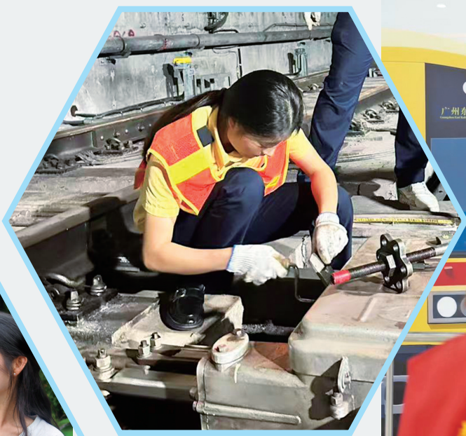
王霞在地铁隧道内进行设备检修。
