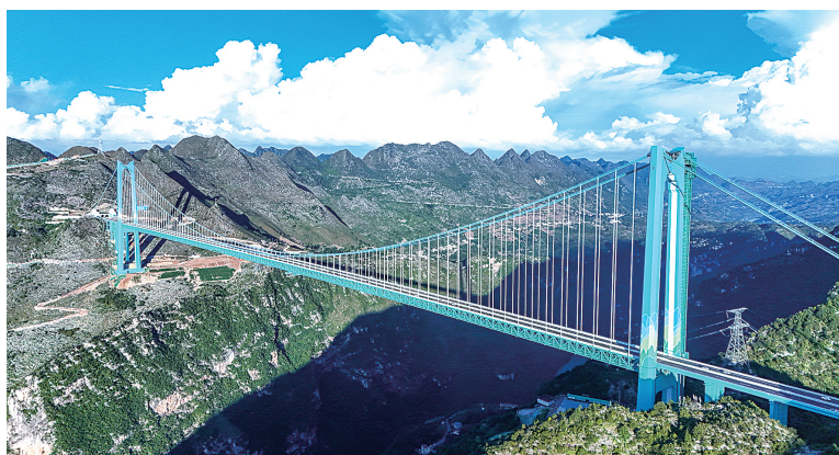
花江峡谷大桥。李允凤 摄(影像贵州)
