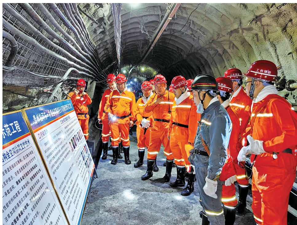
贵州理工学院科研团队的“采动应力作用下巷道大变形围岩控制技术”在盘州市松河一井煤矿实施。
