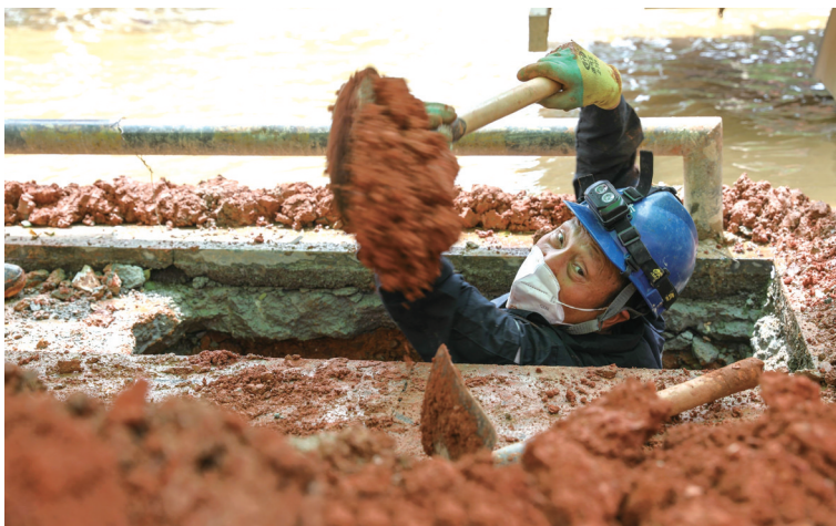
抢修供电设施。
