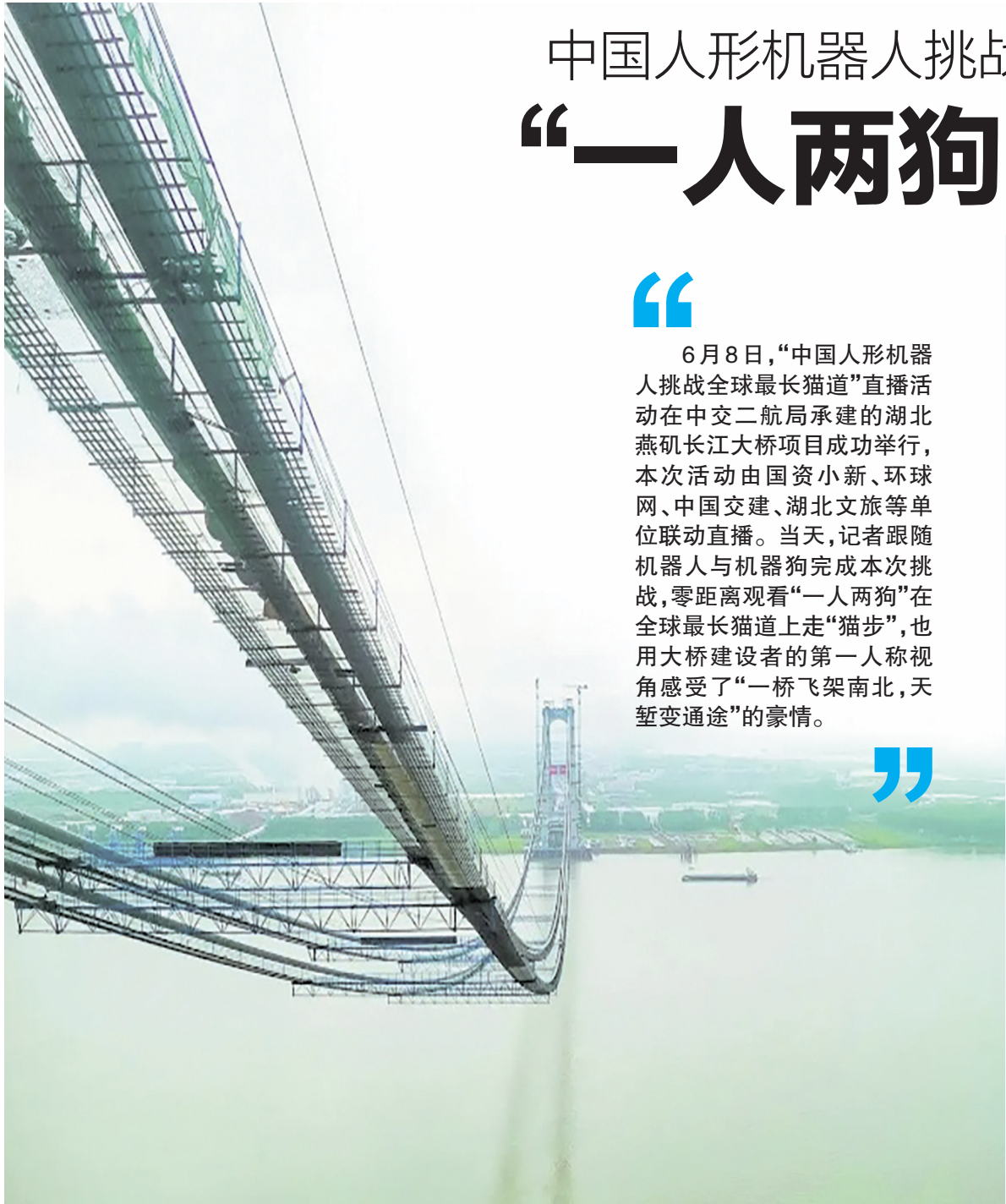
修建中的湖北燕矶长江大桥。
