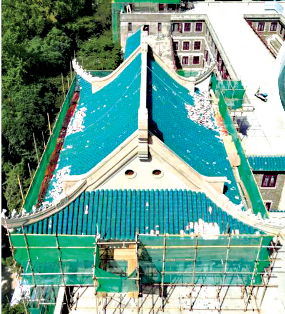
樱顶阁楼屋面琉璃瓦修复现场。图据长江日报
